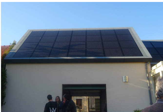
Visite d'une maison ayant fait l'objet d'une rénovation BBC à Chevincourt
